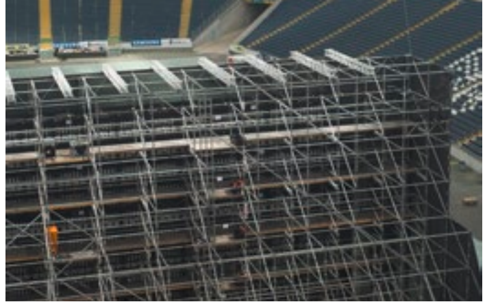
Die LED-Videoleinwand: Sie ist auf einem 40 Tonnen schweren Stahlgerüst montiert und besteht aus 336 Modulen
