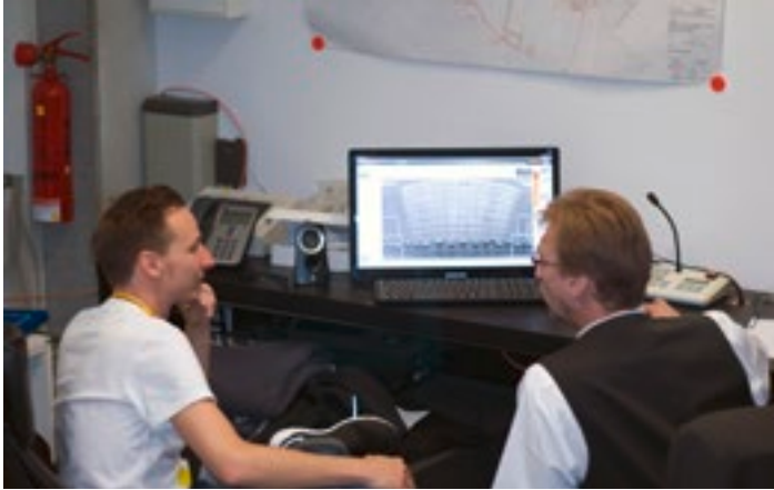
In der Leitwarte: Die Software stellt in Echtzeit die Temperaturen der Videoleinwand dar und kann automatisch Alarm auslösen
