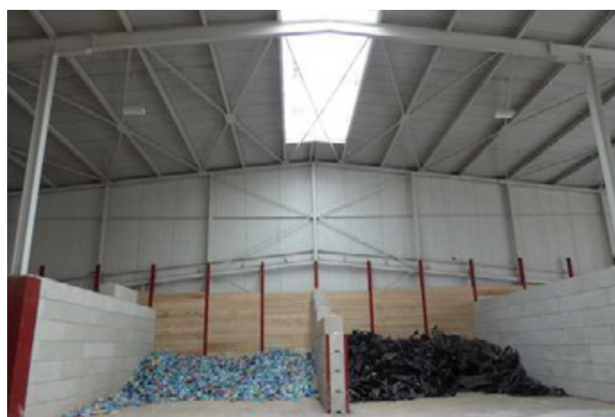
Bild (CBG1401.jpg): Große Lagerhallen mit Recyclingmaterial stellen häufig eine große Brandgefahr dar.
