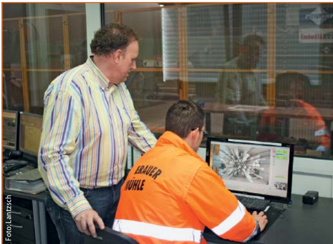
Abb. 2: In der Leitwarte werden das Panorama-Thermografiebild und das reale Videobild angezeigt. Die Mitarbeiter können dadurch schnell und sicher entscheiden, ob tatsächlich ein Feuer ausgebrochen ist.
