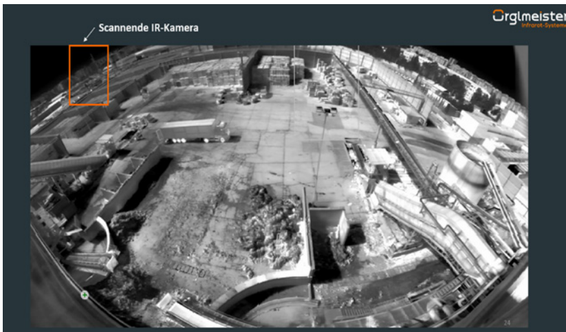
Bild 7: Hochauflösende Panoramathermografie eines Außenlagers Quelle: Orglmeister
