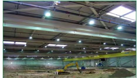
Bild 20: Verfahrbare Halle zum Rückbau mit IR-Überwachung
