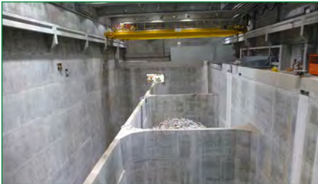
Bild 11: Bunker der Spreerecycling in Spremberg
