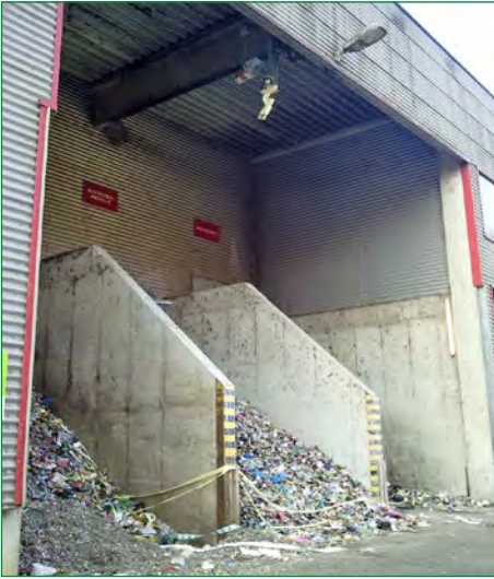
Bild 17: Kombinierte IR-Detektion mit automatischem Löschen (Werfer)
